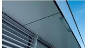
Balcony claddings | Habillage de balcons | Balkonverkleidungen
